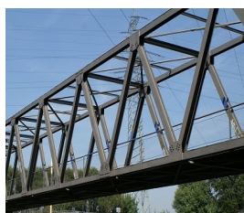
Passerelle pour vélos (Allemagne)
