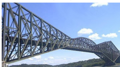
Pont de Québec (Canada)
