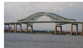
Hart bridge (ETATS UNIS)
