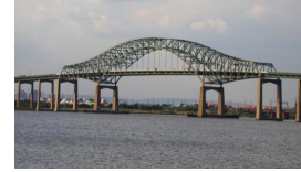
Hart bridge (ETATS UNIS)
