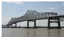
Story bridge (AUSTRALIE)
