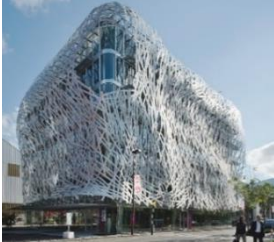
Immeuble Manny, Nantes, 2009. Agence TetraR Résille (structure) métallique Source : caue-observatoire.fr
