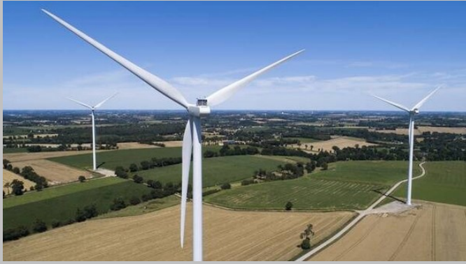
Un parc éolien en Bretagne à côté de Rennes (source Ouest France).
