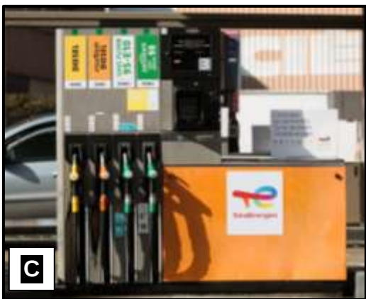
Pompe multi-carburant Total Énergie
