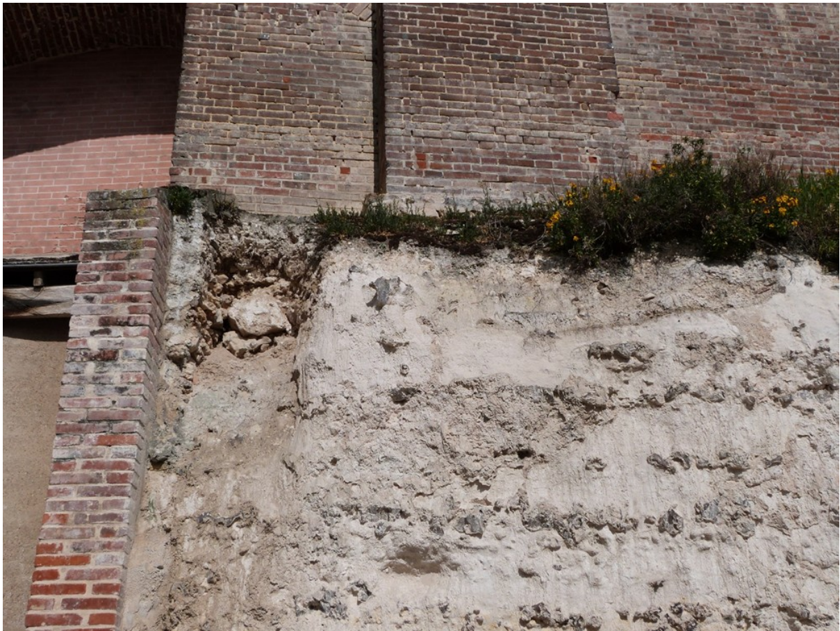
Calcaire crayeux du Santonien (Crétacé supérieur) avec zones d'érosion sous le mur. (Photo E. JAMMART)
